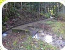
加露沢水門（取水口）
